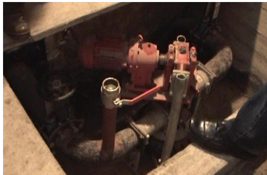
Membránové čerpadlo na prepravu substrátu na jeden deň.
