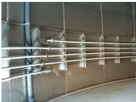
Vnútrotný ohrievací systém
