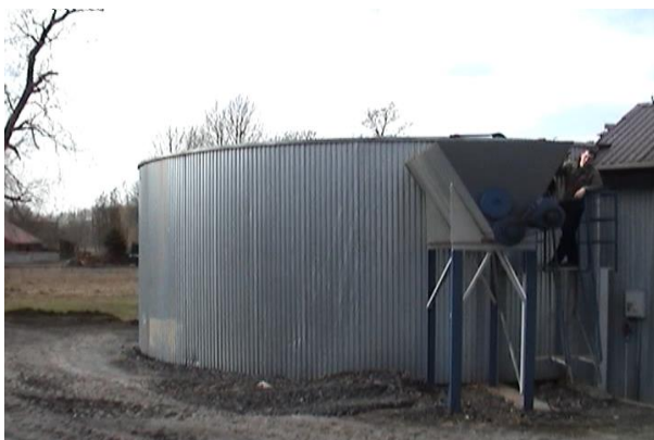
Vertikálna fermentačná komora
